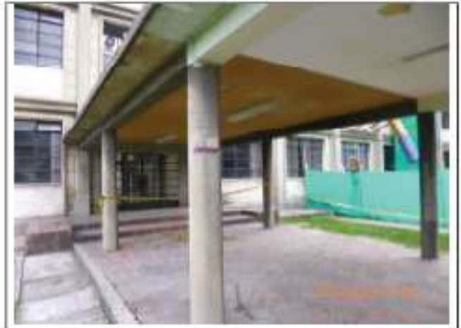
Foto 4: TIPOLOGIA ESTRUCTURA BLOQUE 3, SISTEMA DE PORTICOS. ESTA ES UNA CARACTERISTICA EN LOS BLOQUE 2-4
