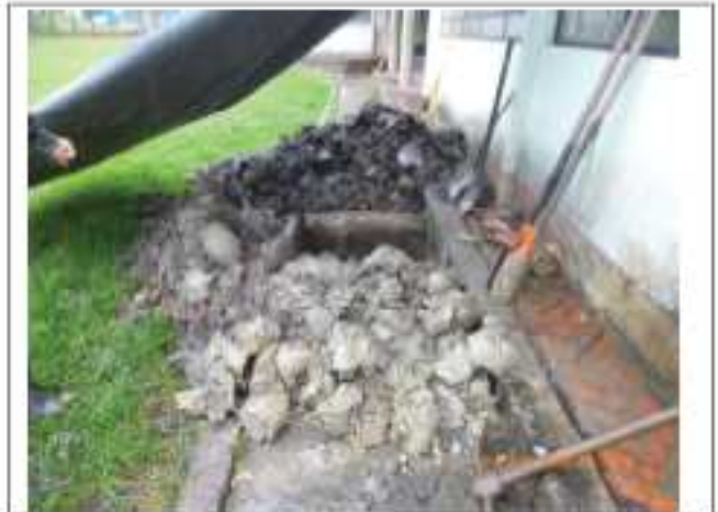
Foto 2: EXPLORACION DE CIMENTACION DEL BLOQUE 3
